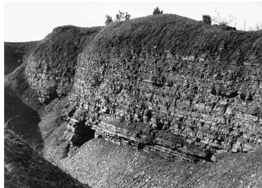
Fot. 5 Kajetanów, odsłonięcie permskich łupków marglistych w nadkładzie czarnych wapieni nadających się do produkcji marmurów (niewidocznych już na fotografii). Zdjęcie J. Fijałkowskiego z 1951 r. Ze zbiorów Muzeum Narodowego w Kielcach, MNKi/Pf/201
