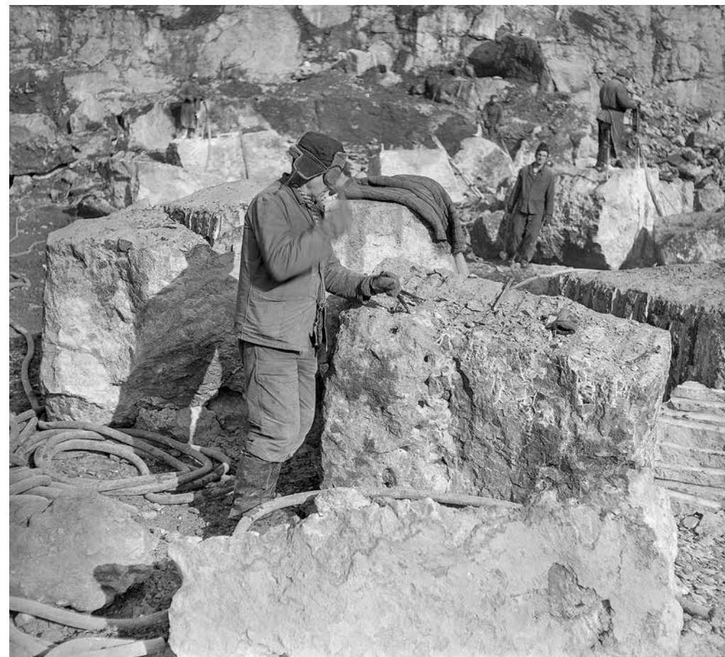
Fot. 28 Formowanie bloku w marmurołomie „Zygmuntówka” na Czerwonej Górze, 1971 r. Fot. Z. Rubinowski
