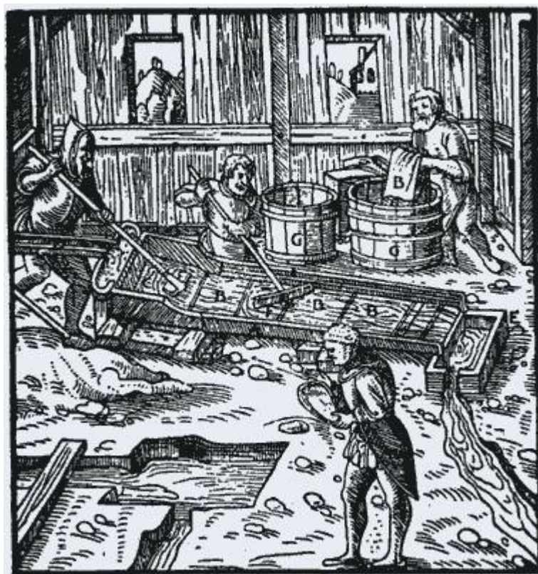
Jedna z licznych odmian płuczek czyli urządzeń do „ślichowania”. Rycina z dzieła Georgiusa Agricoli „De re metallica libri XII” z 1556 r.
