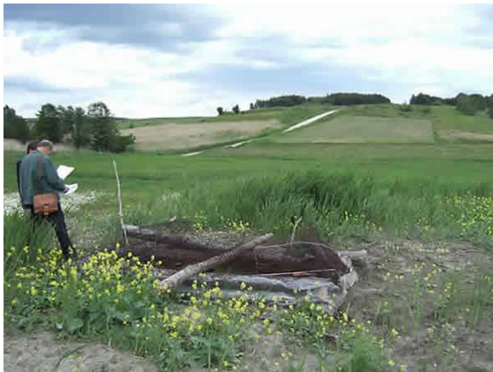
Prowizorycznie zabezpieczony szyb nadradcy Beckera w Gadawie. Fot. G. Herman
